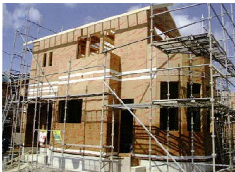
外壁下地（耐力壁）
